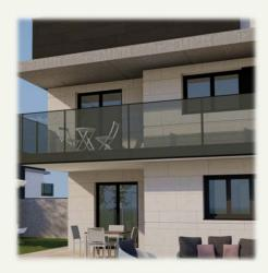
El acristalamiento previsto se realizará con vidrio tipo **Climalit de doble cristal y cámara deshidratada intermedia de elevado confort térmico y acústico.** Las puertas irán dotadas de vidrio de seguridad.
